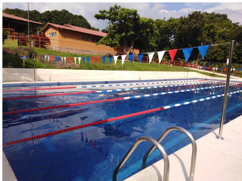
Fotografías corresponden a la Gradería, Centro de Capacitación y Piscina Semiolímpica.
